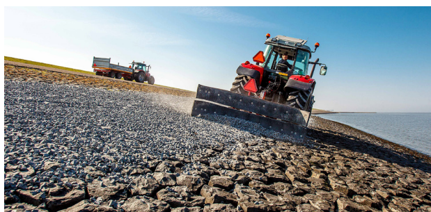
Bekleden van een dijk
