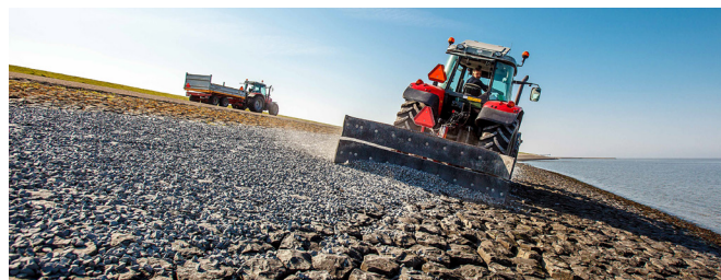
Bekleden van een dijk
